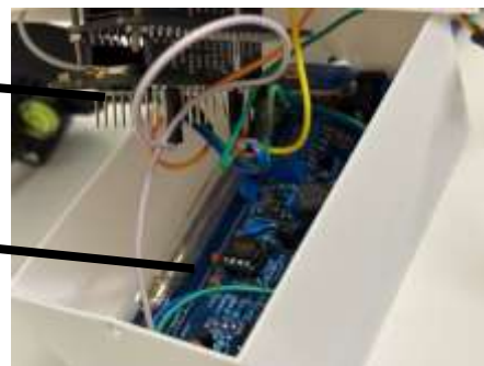
fig. 2 Stația experimentală cu carcasa deschisă
